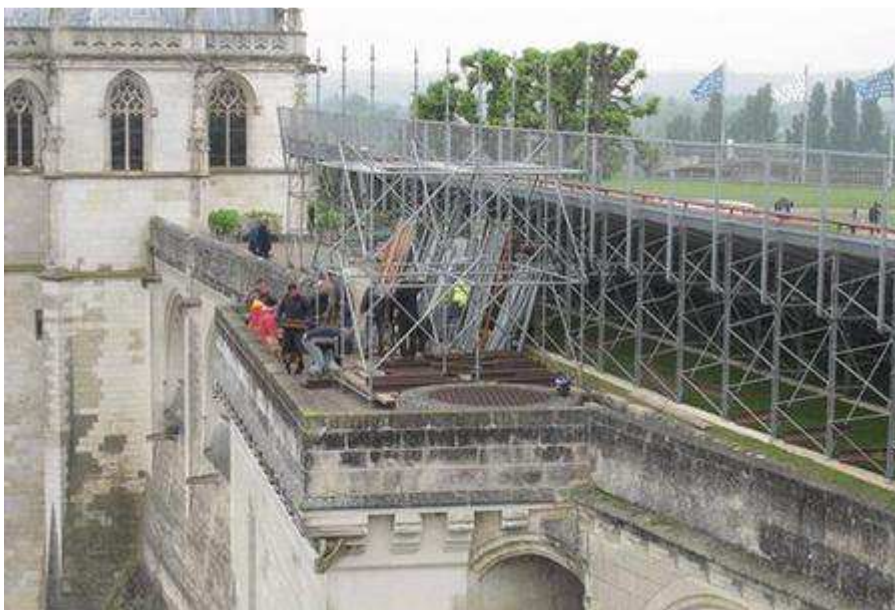
Montage et souci de sécurité.
